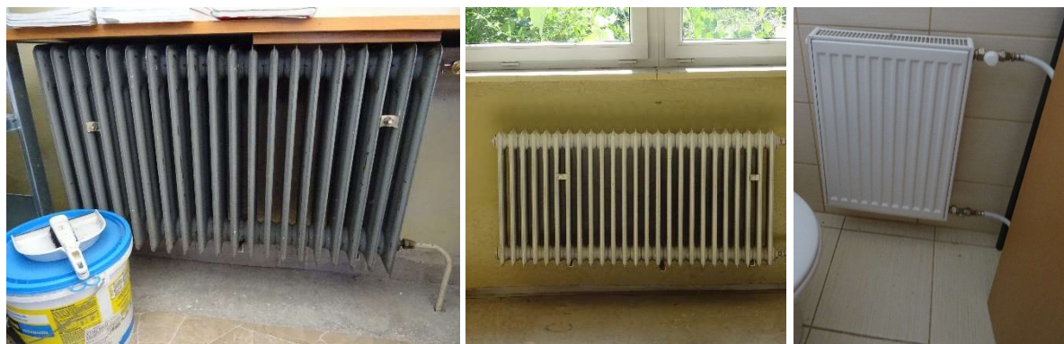
Obr. 17: Vykurovacie telesá
