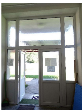
Obr. 16: Otvorové konštrukcie – plastové vstupné dvere
