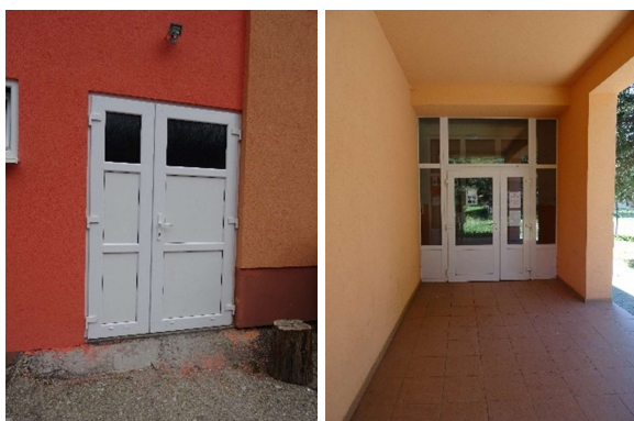
Obr.14: Otvorové konštrukcie – dvere s plastovým rámom s dvojitým zasklením
