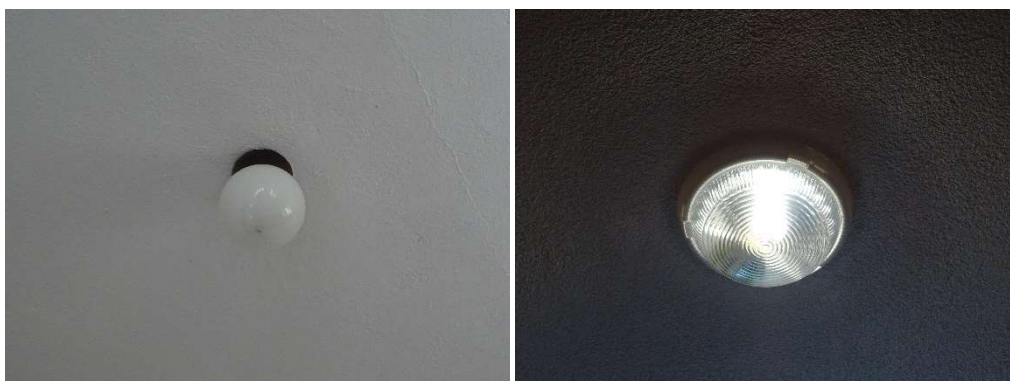
Obr.18: Typ svietidiel – LED svietidlo a LED reflektor na fasáde budovy
