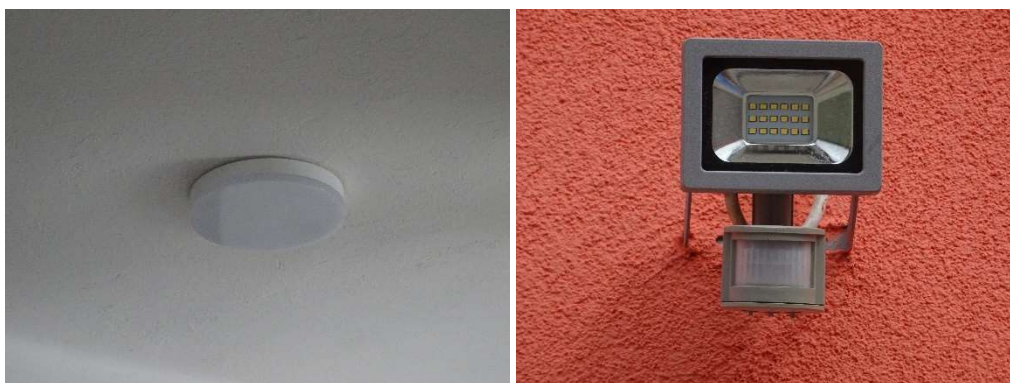
Obr.18: Typ svietidiel – LED svietidlo a LED reflektor na fasáde budovy
