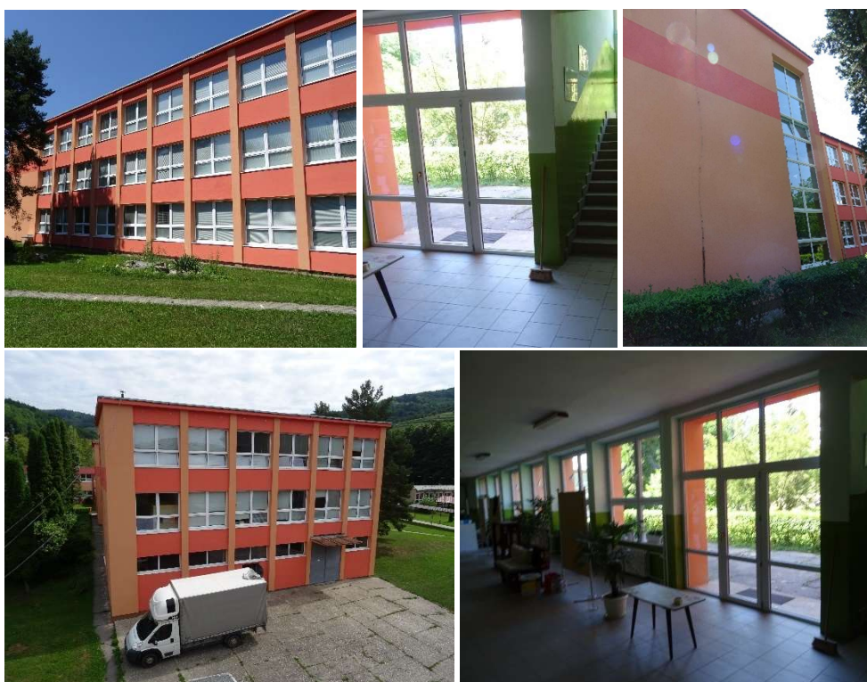
Obr. 14: Otvorové konštrukcie – okná a dvere s plastovým rámom a izolačným dvojsklom
