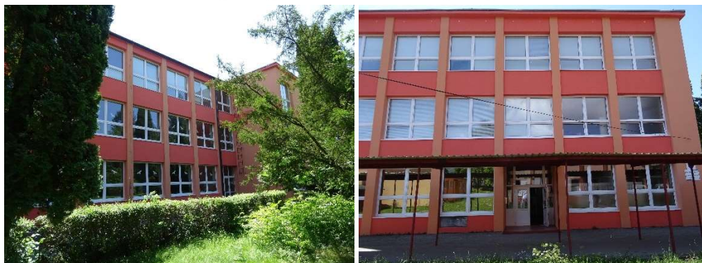
Obr. 10: Objekt základnej školy Hriňová – severozápadný a severovýchodný pohľad
