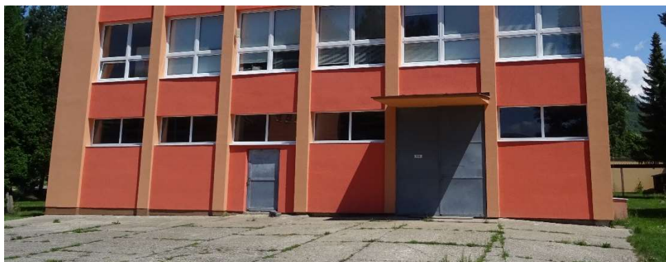
Obr. 15: Otvorové konštrukcie – kovové dvere, ktorými sa vstupuje do technických častí objektu
