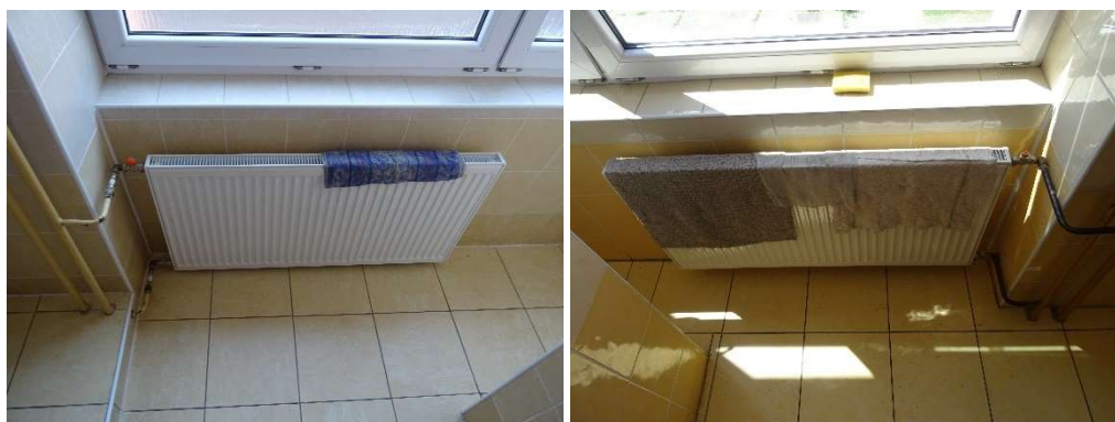
Obr. 20: Doskové vykurovacie telesá v hygienických miestnostiach
